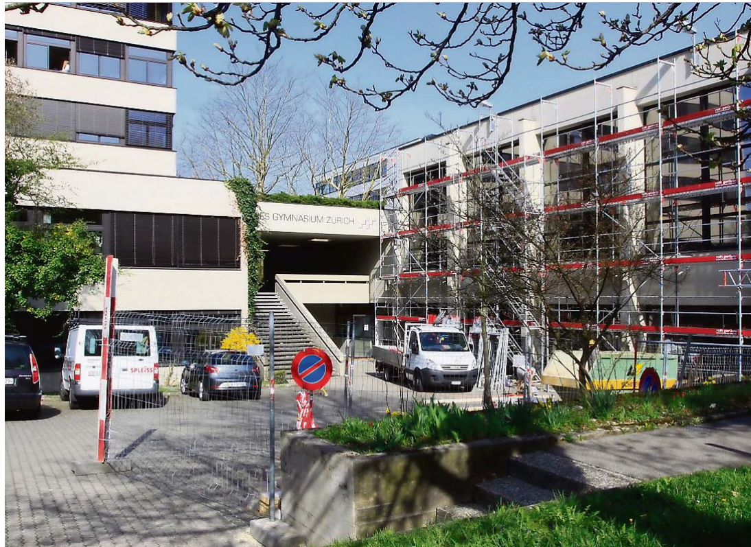
Die Sanierung des Turnhallentrakts (rechts) hat in diesen Tagen begonnen.
